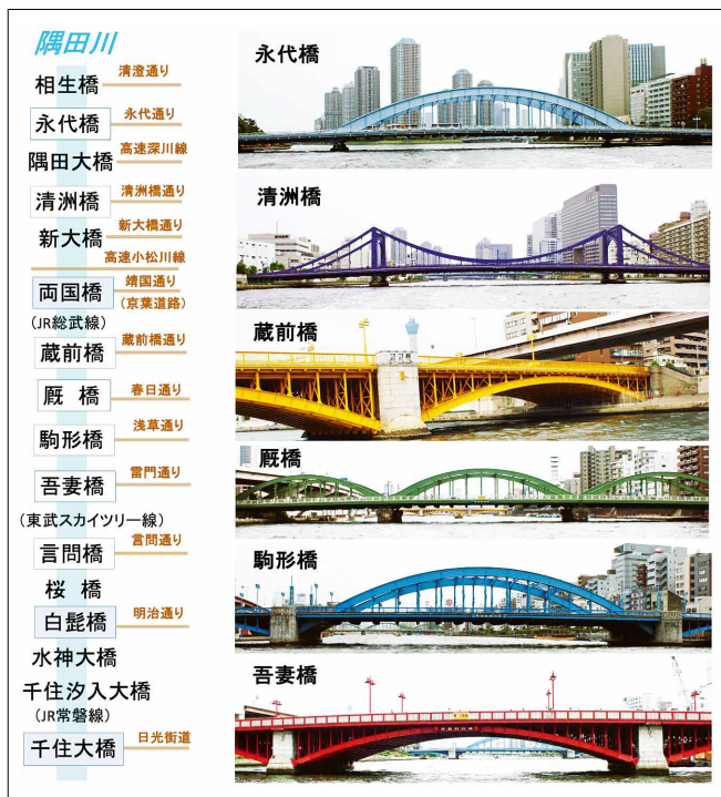
図3 隅田川橋梁の現状。四角で囲った橋は震災復興期にできた橋(震災復興橋梁)、うち白い四角は帝都復興事業によるもの【武村(2023)】。
